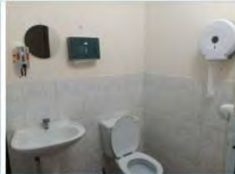
MEZZANINE BAÑO DIRECCION ADMINISTRATIVA FINANCIERA
